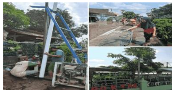
Sumber: (Dokumentasi Penulis, 2024) Gambar 6. Pemasangan Sumur Bor dan Listrik
