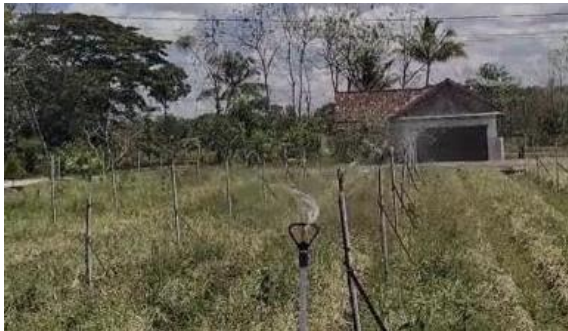
Sumber: (Dokumentasi Penulis, 2024) Gambar 7. Pemanfaatan PLTS untuk Penyiram Tanaman dengan Sprinkle
