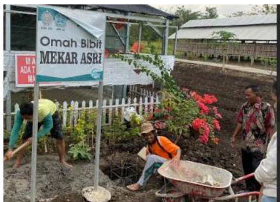
Sumber: (Dokumentasi Penulis, 2024) Gambar 8. Proses Pembuatan Pondasi PLTS
