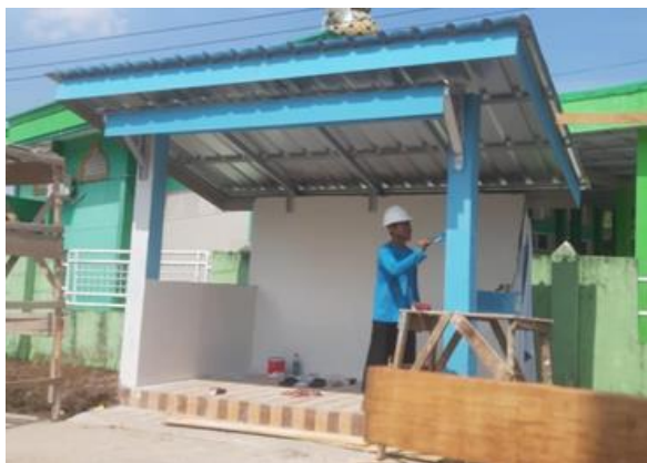
Sumber: (Dokumentasi Penulis, 2025) Gambar 9. Kondisi Fisik 90%
