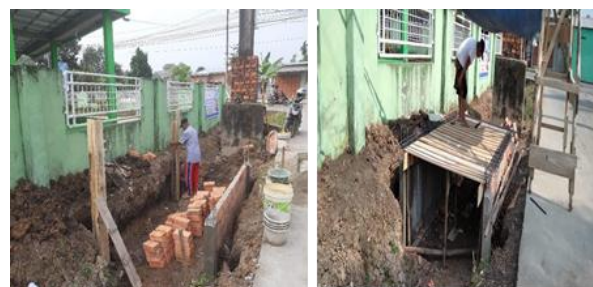
Sumber: (Dokumentasi Penulis, 2025) Gambar 7. Kondisi Fisik 10%
