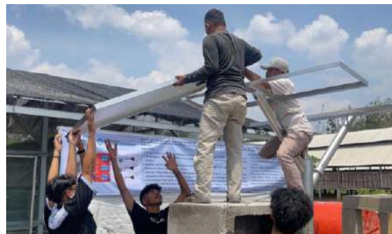
Sumber: (Dokumentasi Penulis, 2024) Gambar 5. Pemasangan PLTS di Lumbang Mataraman
