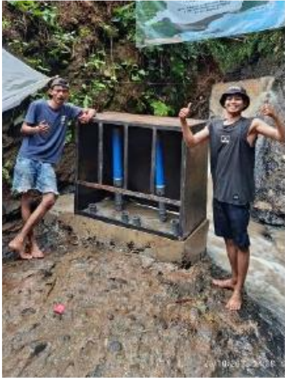
Sumber: (Dokumentasi Penulis, 2025) Gambar 4. Kondisi Safety Cage Terpasang Sebagai Proteksi Unit Pompa
