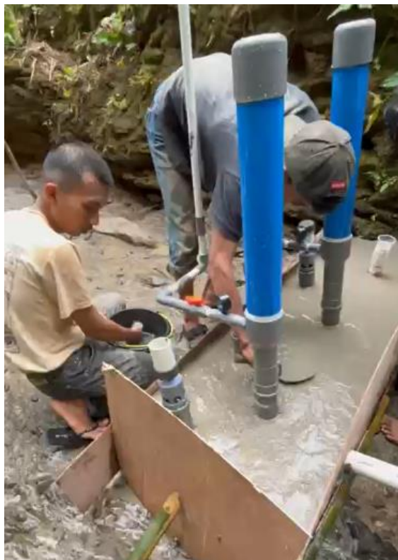
Sumber: (Dokumentasi Penulis, 2025) Gambar 3. Pemasangan Pompa Hydram Pada Dudukan Cor
